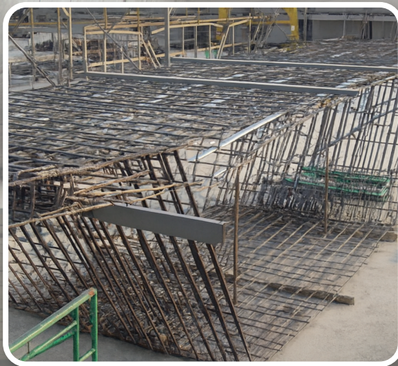
รูปที่ 5 ลักษณะโครงสร้างของเหล็กเสริมภายใน Segmental Box Girder
