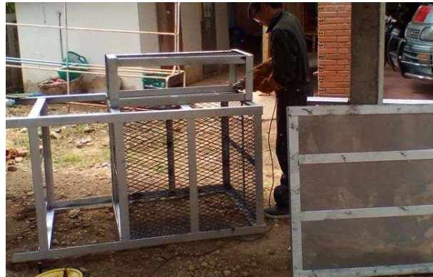
เชื่อมเหล็กตะแกรงโครงเตา
