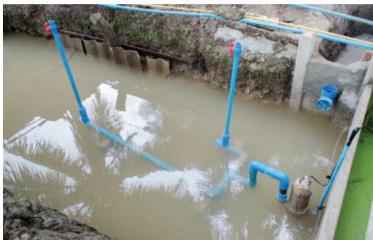
ง) บ่อที่ 4 เติมอากาศครั้งที่ 2
